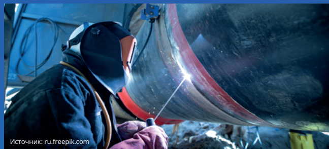
Сварка — основной технологический процесс при строительстве и ремонте газонефтепроводов
